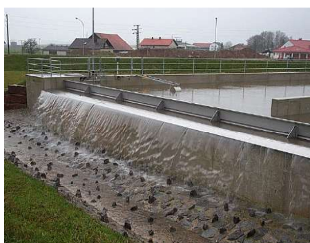
FluidWing (Crête profilée pour mesure de déversements)
