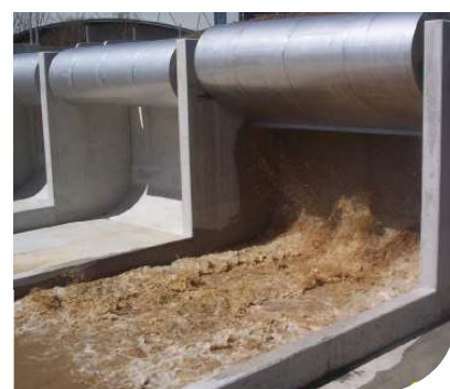
Fluidflush (Bac de rinçage)
