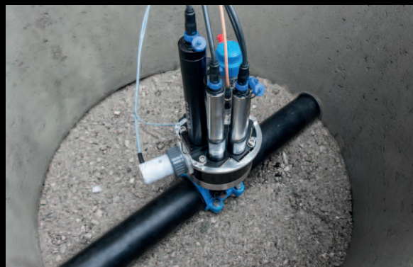
Exemple d'installation dans un trou d'homme
