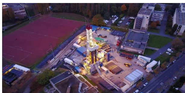
Vue aérienne du chantier de forage subhorizontal de Cachan (450 m 3 /h)
