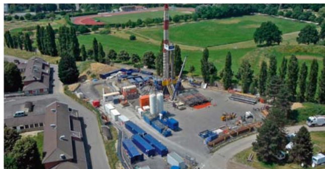
Chantier de forage profond
