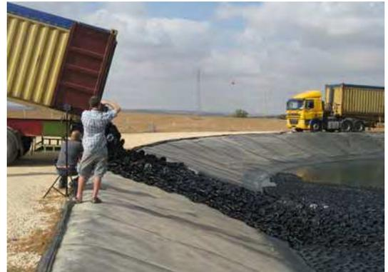
et les tuiles sont simplement versé sur la surface, où, après la couverture flottante Hexa-Cover® et distribuer automatiquement créer une couverture cohérente
