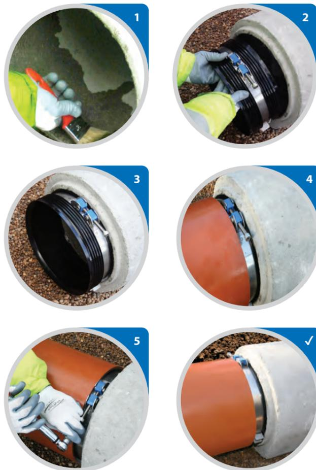
1. Assurez une surface propre sans défaut. Pour les tuyaux en béton, lubrifiez la surface intérieure.
