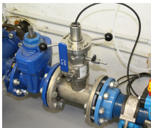
Montage de la Turbimax CUS52D sur conduite.
