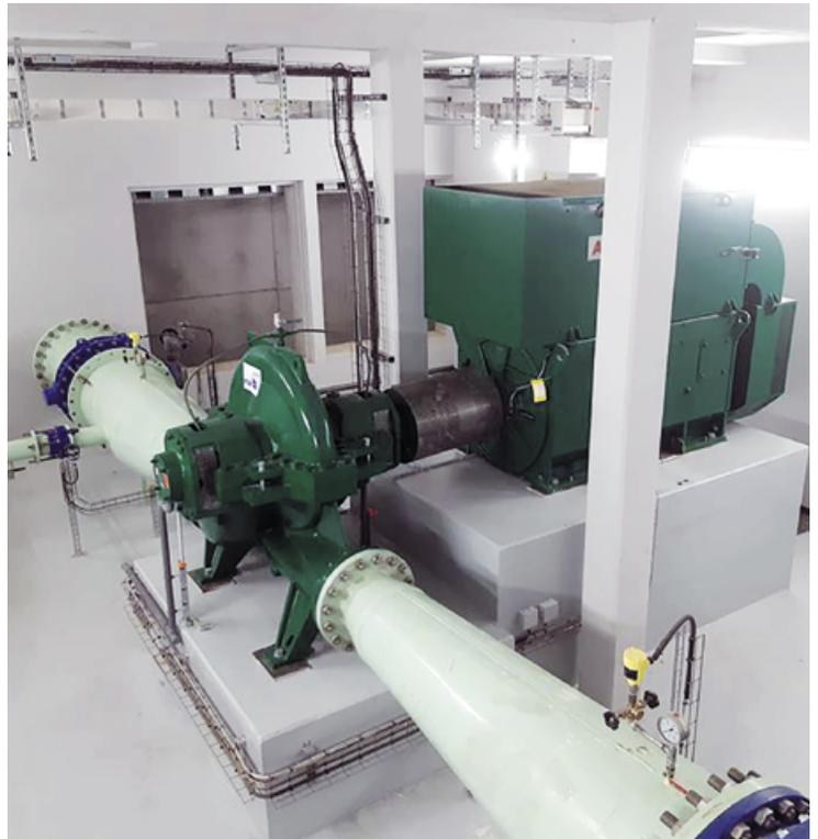
La pompe RDLO 350-850 A SC, pompe la plus puissante installée par la Société du Canal de Provence avec un moteur de 2,4 mégawatts alimenté en 690 volts, une puissance nécessaire pour satisfaire les besoins des usagers et des nombreux estivants.
