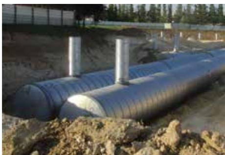
La rehausse est en acier galvanisé. Elle est livrée en option sur demande et permet de faciliter l'accès à la cuve. Un couvercle en acier est fixé sur la rehausse à l'aide de boulons. Il n'est pas prévu pour supporter le passage de véhicules.
