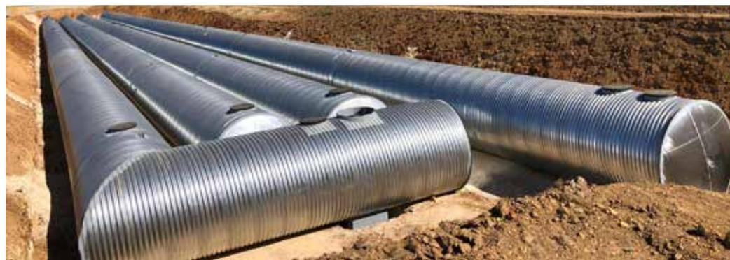
Contrôler les déformations de la buse notamment en mesurant le diamètre vertical entre 2 points de repères matérialisés à la peinture par l'entreprise au sommet et au radier de celle-ci. Ces mesures seront faites dans au moins 3 sections de la buse, après achèvement complet du montage des tuyaux et après que les remblais aient atteint la génératrice supérieure (voir schéma ci-contre).
