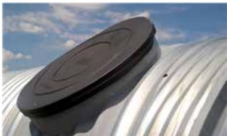
Le trou d'homme est réalisé en acier plat galvanisé. Il est cylindrique d'un diamètre et d'une hauteur à définir selon les besoins. Un plateau en acier, fixé par des boulons galvanisés peut être livré en option. Des manchons taraudés ou bobines peuvent être fixés sur le plateau afin d'y ajouter des accessoires type évent, robinet flotteur...
