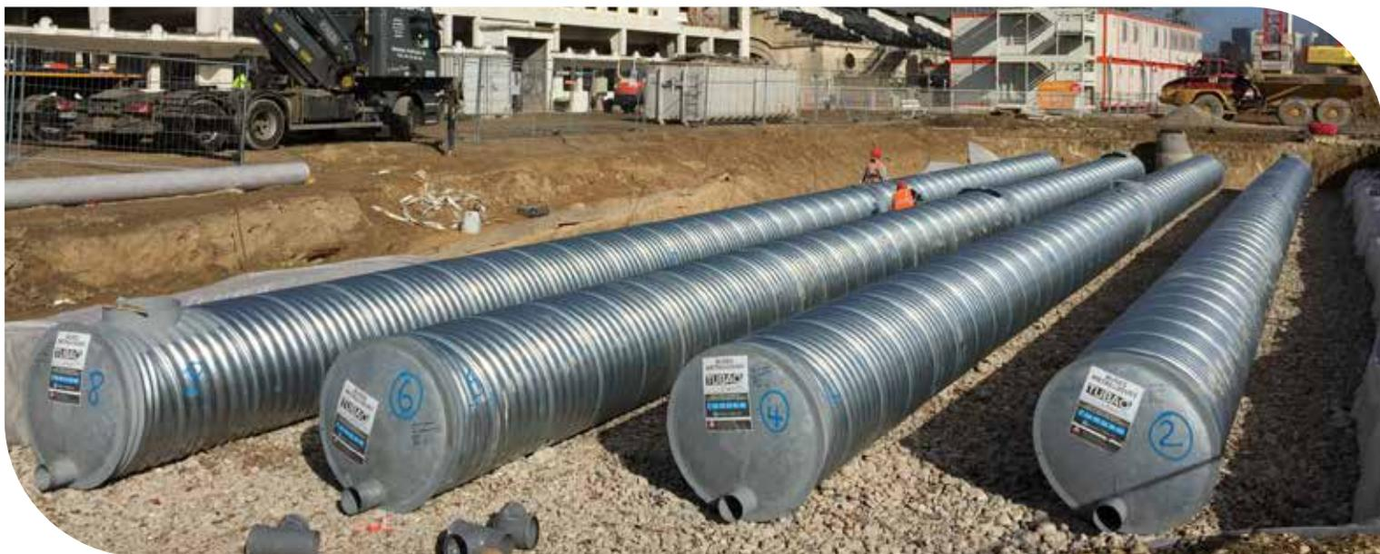
**Un bassin / puits d'infiltration visitable est un ouvrage qui retient les eaux pluviales produites lors d'un orage et les infiltre directement dans le sol, sans encombrer les réseaux.**
