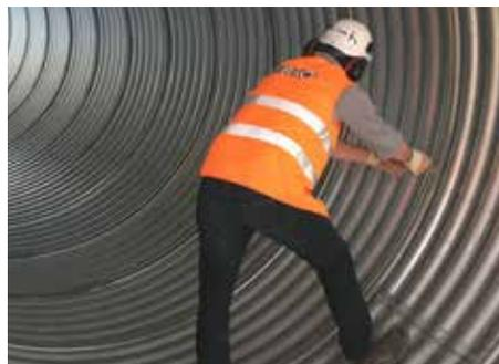
L'ensemble des agrafes et soudures de la citerne peut être recouvert d'une résine d'étanchéité élastique à forte adhérence.
