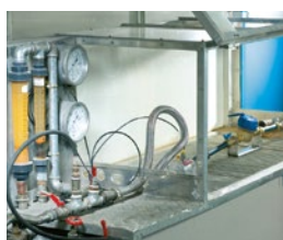
Banc d'essais hydrauliques
