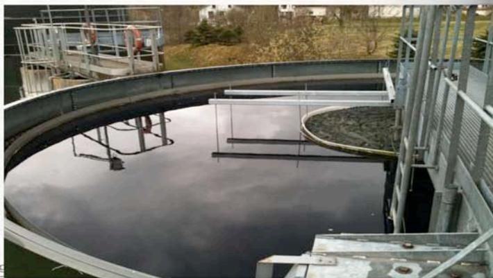
Ce système breveté de déflecteurs montés sur le pont racler transforme les courants centrifuges de fond de clarificateur en contre-courants centripètes.
