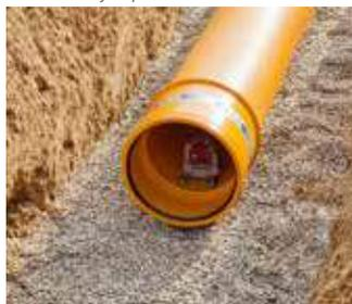
Fig. 3-26 Pose avec de faible pente
