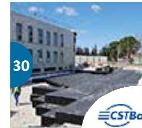
Infiltration & régulation des eaux pluviales enterrées
