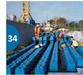
Infiltration & régulation des eaux pluviales enterrées
