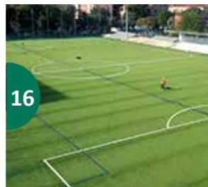
Aménagement de terrains de sport
