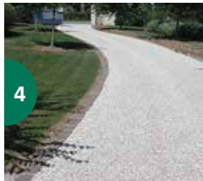
Stabilisation de graviers en milieu paysager
