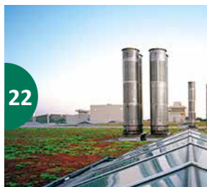
Aménagement de toitures végétalisées
