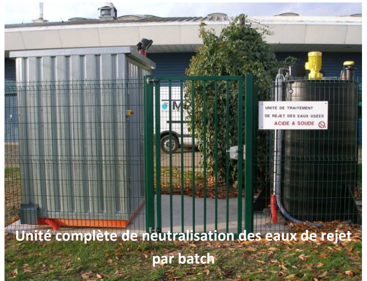
Régulation de pH et de Nickel en traitement de surface
